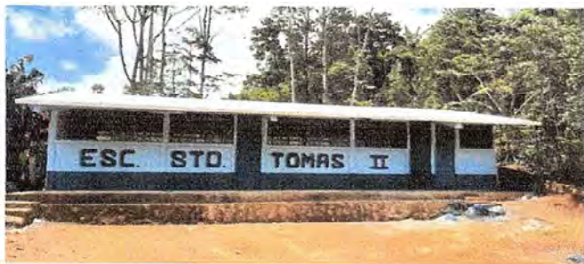
Foto1: ESTRUCTURA METALICA, ENTECHADO AULA Y CORREDOR, SALON 3. SEGÚN CROQUIS Y PISO CERAMICO EN EL CORREDOR
