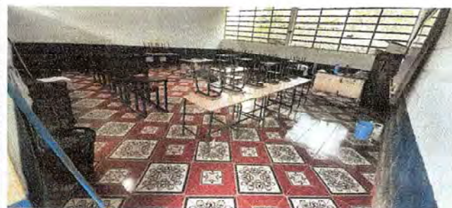
Foto 4: REPARACION O SUSTITUCION DE PISO
