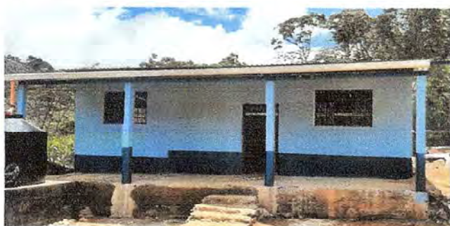
Foto 5: REPARACION DE CORREDOR
