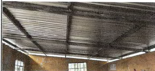
Foto 2: ESTRUCTURA DE TECHO
